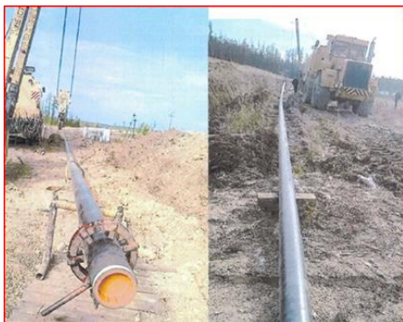
Концы труб с внутренним покрытием и установленными наконечниками из коррозионностойкой стали
